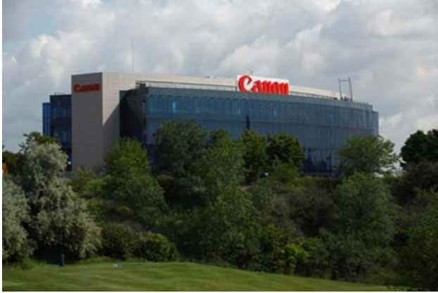
Foto 3: La nueva sede de Canon en España muestra el 60% de ahorro en coste de energía para la iluminación y reducción del 40% del coste de energía para aire acondicionado, gracias al uso de KNX.
