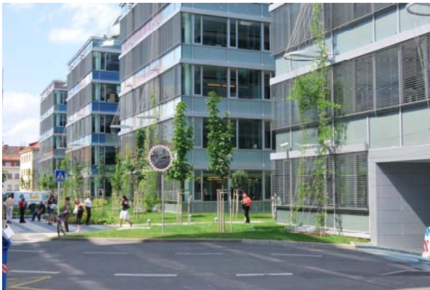
Foto 2: La sede de la empresa de la compañía de seguros más grande en la República Checa puede producir un mejor balance energético de 60% gracias a la automatización en red de todas sus funciones del edificio a través de KNX.
