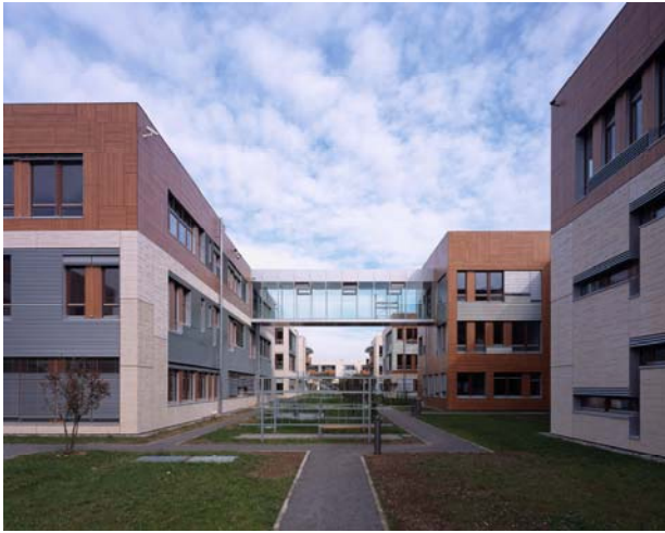
Foto 1: Convincente optimización del control de iluminación con KNX en la sede de la empresa Infineon basado en a hechos concretos: ahorro de energía de más de 100.000 € al año.
